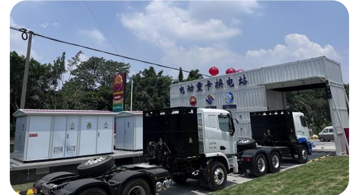
四川宜宾机场路综合能源站——“油、气、重卡换电”综合能源站
