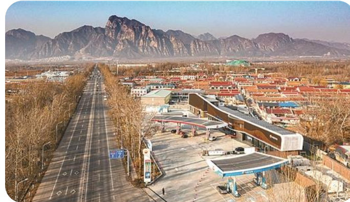
北京金龙综合能源服务站——中国石油首座“油气氢电非”综合能源服务站
