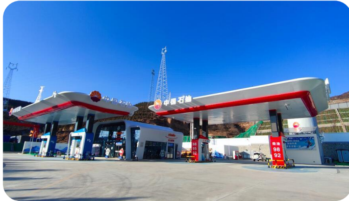
河北崇礼北油氢合建站——中国石油首个新形象标准综合能源站
